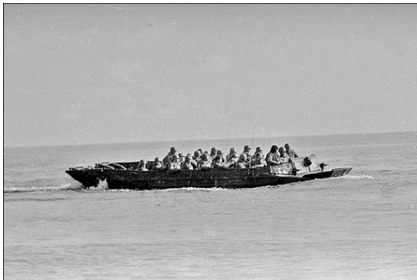
Inżynieryjny transporter pływający PTG K-61 z pododdziałem desantu. Amfibie tego typu stanowiły podstawowy sprzęt desantowo – przeprawowy 3. pułku piechoty morskiej a następnie dywizji desantowej „niebieskich beretów”. PTG mogły pływać z prędkością 10 km/h i miały nośność 5 ton.
