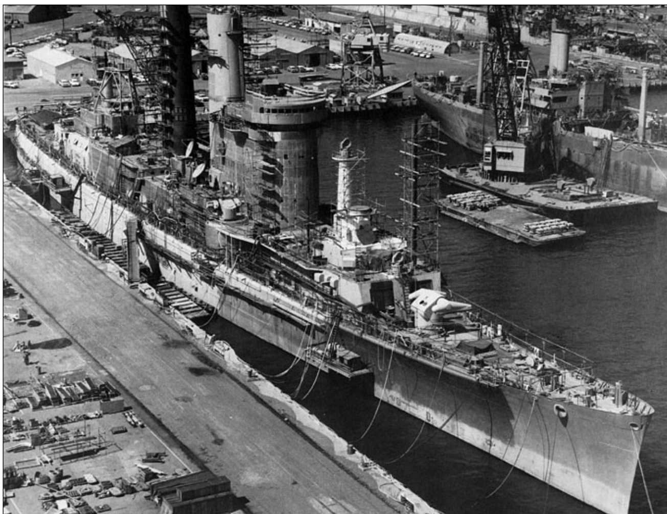
Krążownik rakietowy Chicago w trakcie prac wyposażeniowych w 1961 roku. Widoczna zamontowana już wyrzutnia pocisków SAM-N-6B „Talos” na dziobie oraz prawoburtowa wyrzutnia pocisków Mk 15 „Tartar”, a także usytuowane za nią anteny radarów kierowania SPG-51C.
