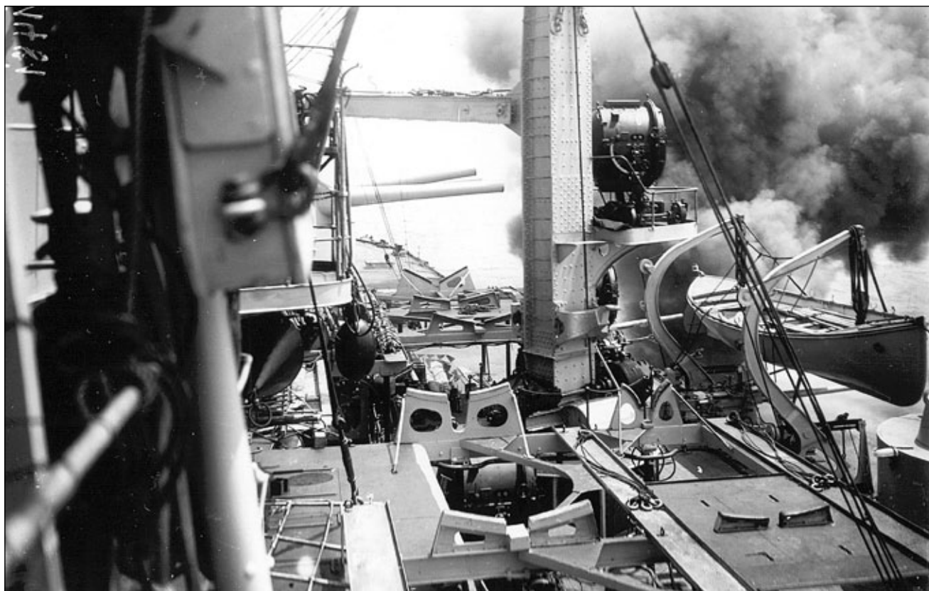
Śródokręcie Prinz Eugen , spojrzenie na lewą burtę w kierunku rufy. Widoczny dźwig okrętowy, wysięgnik i reflektor (aust. nm. „Projektor”) platformie dźwigu, rostry, lufy armatnie wieży nr III i jedną z łodzi na żurawikach. Fot. zbiory ARGE
