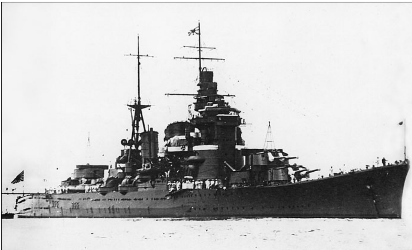
Ashigara w sierpniu 1929 r. Fotografia dobrze ukazuje początkowy wygląd kadłuba krążowników z burtowymi wyrzutniami torped oraz pojedynczymi działami kal. 120 mm. Fot. „Ships of the World”
