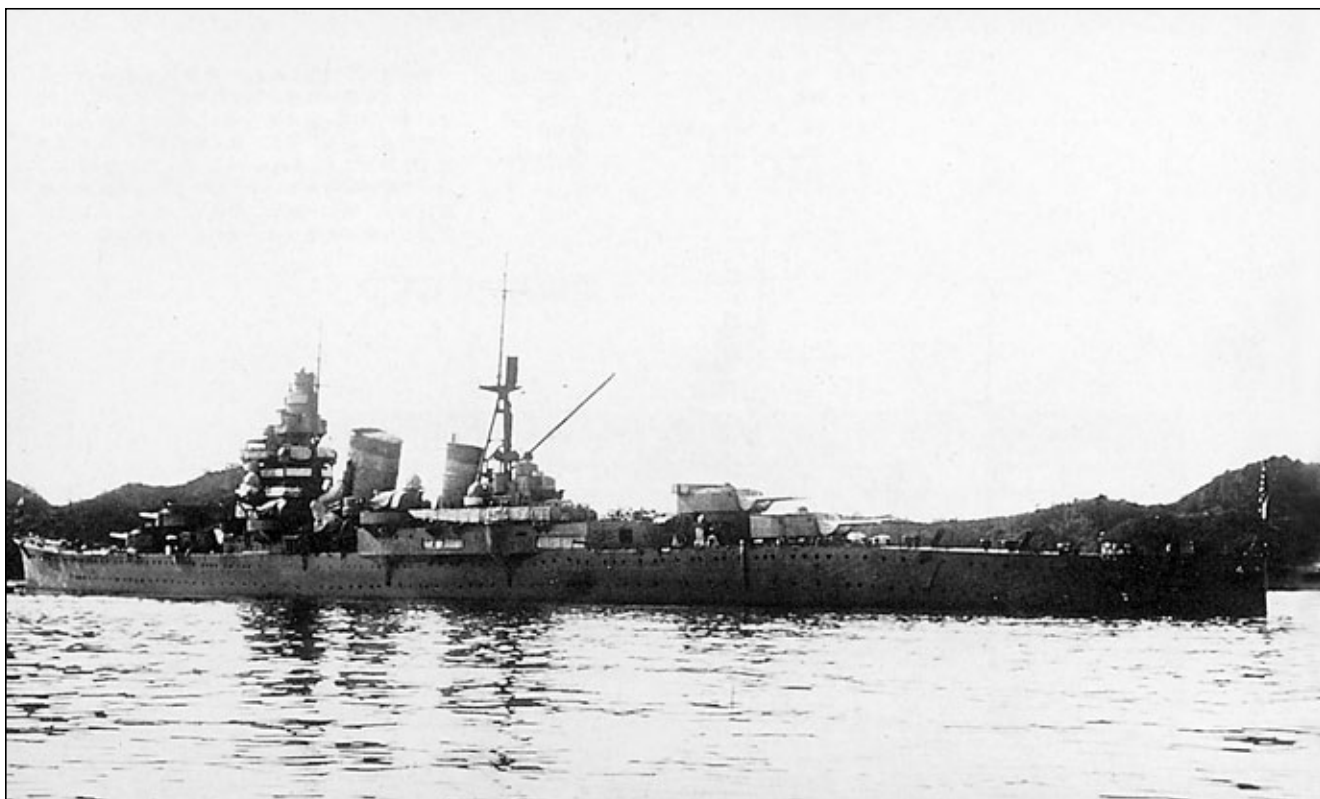
Myōkō w pierwotnej konfiguracji. Zwraca uwagę odmienny typ dalocelownika stojącego na szczycie dziobowej nadbudówki. Widoczne również pozostałe systemy kierowania ogniem.
