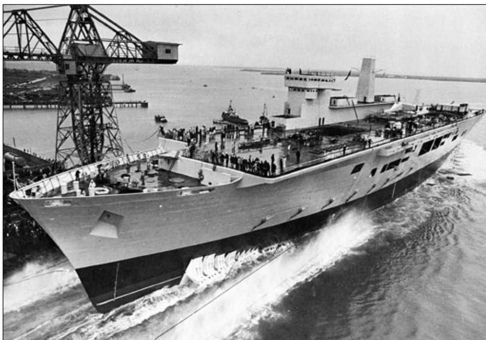
Wodowanie prototypowego Invincible w stoczni Vickers w Barrow-in-Furness, Uwagę zwraca pierwotny kształt pokładu dziobowego. Fot. „Warship International”
