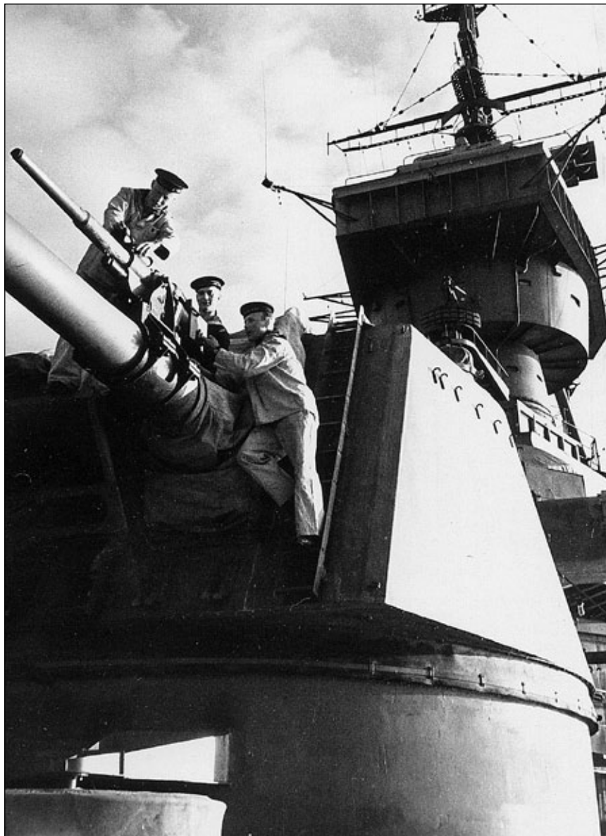
Dla celów szkoleniowych montowano też na lufach dział kal. 152 mm działka kal. 45 mm. Na fotografii widzimy jego przebieg na krążowniku Ordżonikidze , 1954 r.
