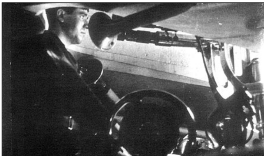
Wnętrze wieży dział kal. 305 mm. Widoczne rury głosowe, którymi przekazywano namiary dla przyrządów celowniczych. Fot. zbiory Dionicio García Flórez
