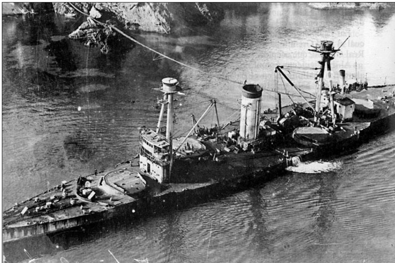
Akcja ratownicza na España . Wieże artylerii głównej już zdemontowano, widoczny kabel komunikacyjny łączący okręt z brzegiem.
