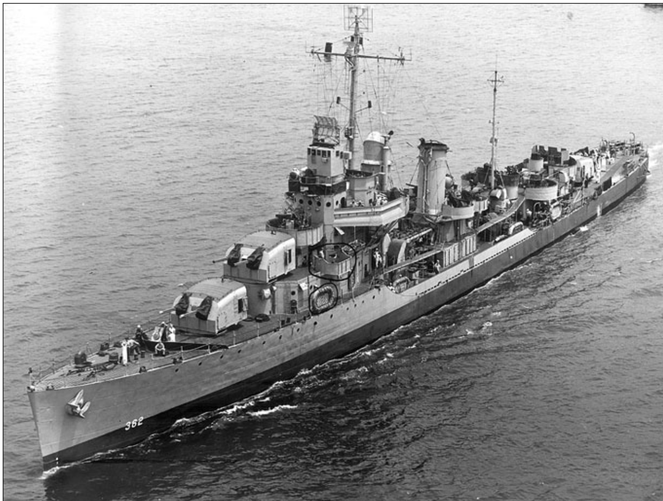
Piękna fotografia Moffet wykonana 13 lipca 1944 roku na wodach Hampton Roads. Wyraźnie widoczny „chodnik” łączący nadbudówkę rufową z pokładem dziobowym. Fot. zbiory Artur D. Baker III
