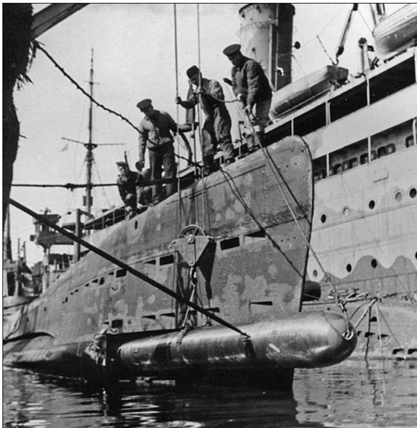
Ładunek torpedy na jeden z okrętów podwodnych typu „Szcz”, obok zacumowana Newa .
