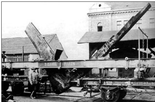
Inną „bronią” Monarch był 11 tonowy podwodny taran, wykonany z żelaza. W rzeczywistości taran był bardziej niebezpieczny dla własnych jednostek niż dla okrętów nieprzyjaciela.
