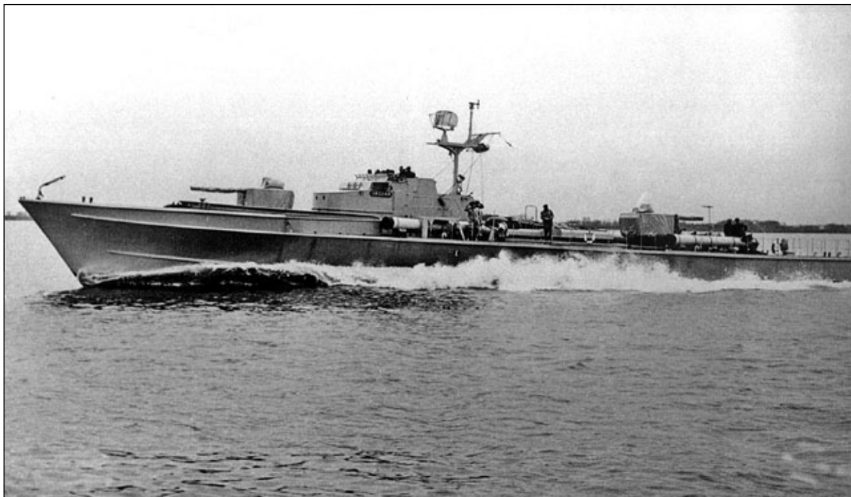
Pierwsza jednostka typu 140, Jaguar . Na prezentowanej fotografii jeszcze z atrapami uzbrojenia i prowizorycznym radarem, podczas prób prawdopodobnie w listopadzie 1957 roku. Wyrzutnie torpedowe nie są jeszcze kompletnie wyposażone.
