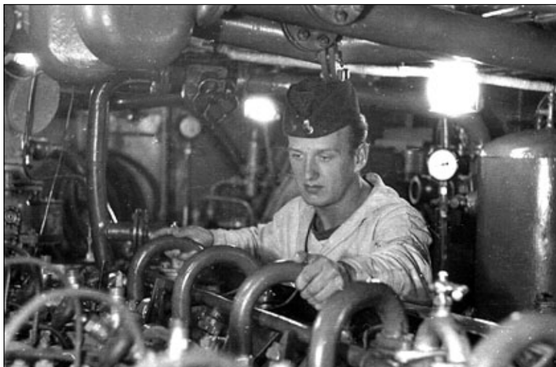
Siłownia nr 1 (silnik lewy) – kontrola temperatury, z tyłu zbiornik hydroforu.
