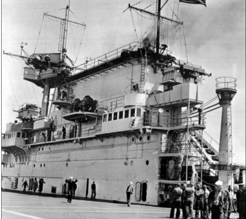
Nadbudówka wyspowa Yorktown od strony pokładu lotniczego. Doskonale widoczny kształt pomostu oraz stanowiska kierowania operacjami lotniczymi, a także dalec celowniki Mk 33 artylerii uniwersalnej. Fotografia wykonana w dniu 7 września 1937 roku w końcowej fazie prac wyposażeniowych okrętu w stoczni Newport News. Fot. U.S. Naval Historical Center
