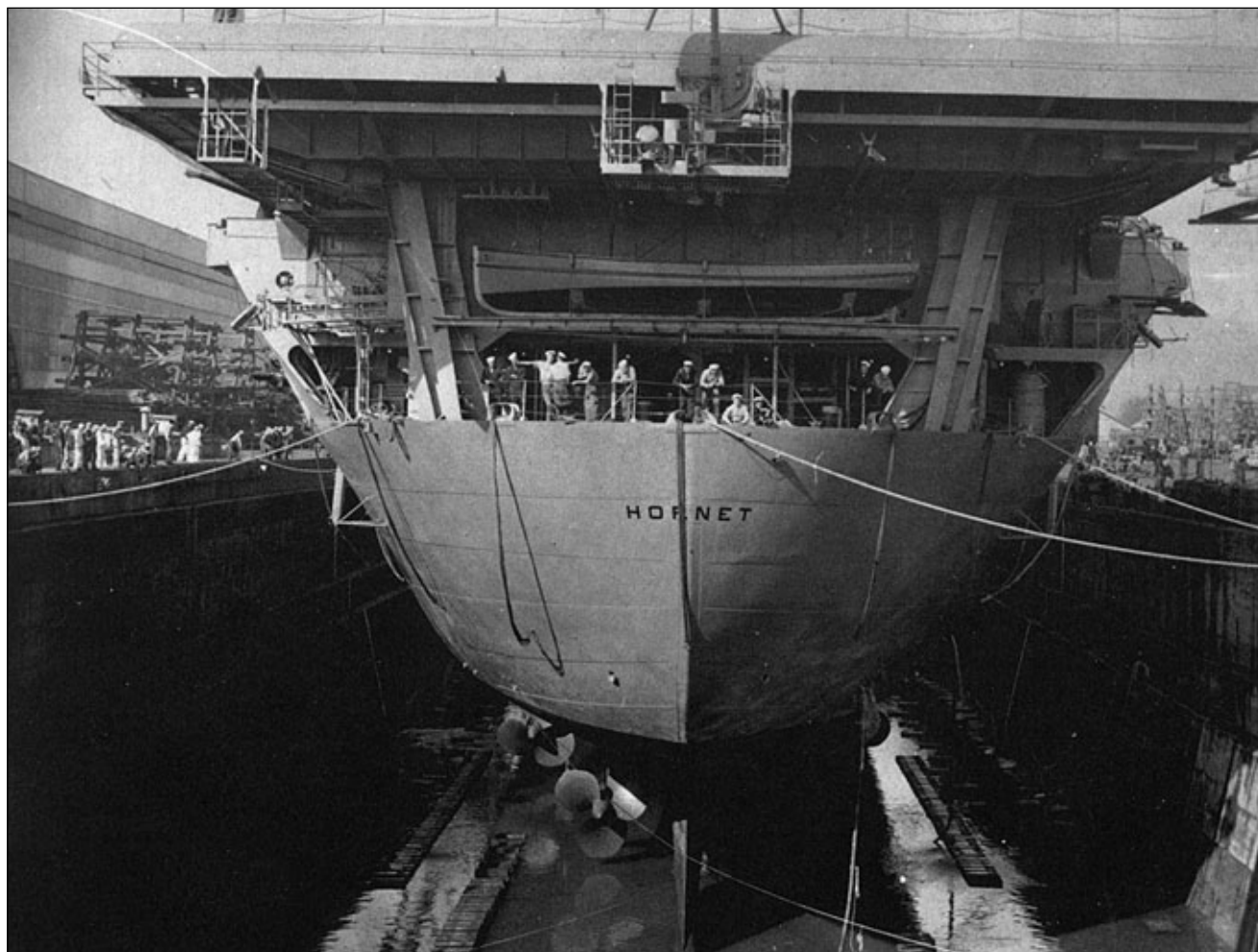
Hornet w suchym doku Norfolk Navy Yard w dniu 19 listopada 1941 roku. Doskonale widoczna konstrukcja rufy okrętu oraz lewoburtowe śruby napędowe i płetwa steru.
