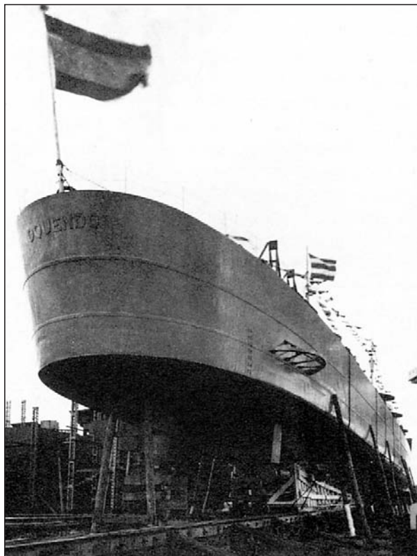
Kadłub niszczyciela Oquendo krótko przed wodowaniem.
