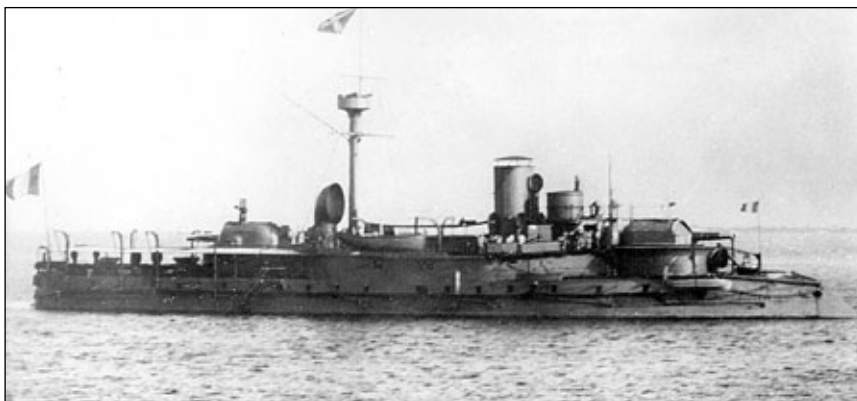
Furieux był typowym francuskim pancernikiem obrony wybrzeża wybudowanym w latach 1878-1887, o wyporności podobnej do typu Monarch (początkowo 5925 ts, a po rekonstrukcji 5638 ts), lecz uzbrojonego jedynie w 2 działa kal. 340 mm o krótkiej lufie, zaledwie 21 kalibrów.
