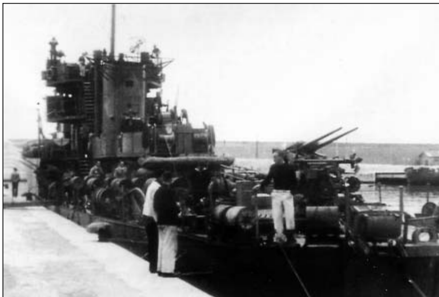
W tej fazie działań wojennych UJ 2221 został dodatkowo uzbrojony w podwójne działko kal. 37 mm, które ustawiono na rufie. Jego fundamenty można zauważyć na poprzednich fotografiach. Liczba zabieranych na pokład bomb głębinowych uległa znacznemu zwiększeniu.
