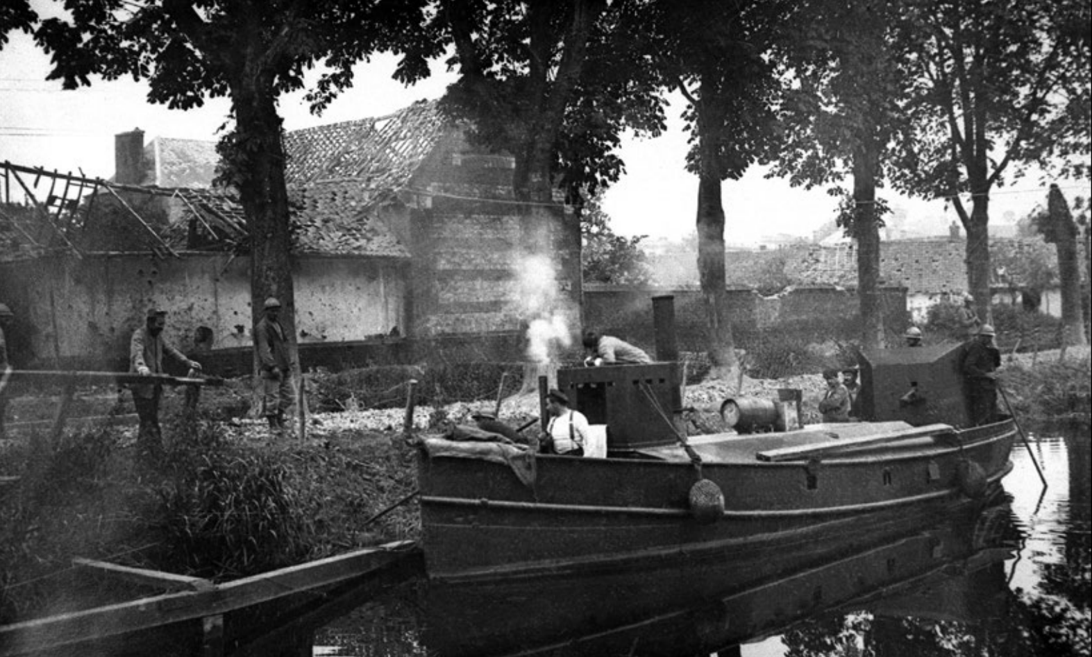
10 metrowa jednostka parowa wchodząca w skład części dywizjonu. Została pieczołowicie opancerzona przez stocznię, aby operować jak najbliżej frontu, a zwłaszcza nieść pomoc kanonierce, która znajdzie się pod ogniem wroga. Zgodnie z przepisami jednostka powinna być wyposażona w 37 mm działo i reflektor, lecz na fotografii wydaje się, iż pod osłoną znajduje się 47 mm działo. Fot. DR, zbiory autora.
