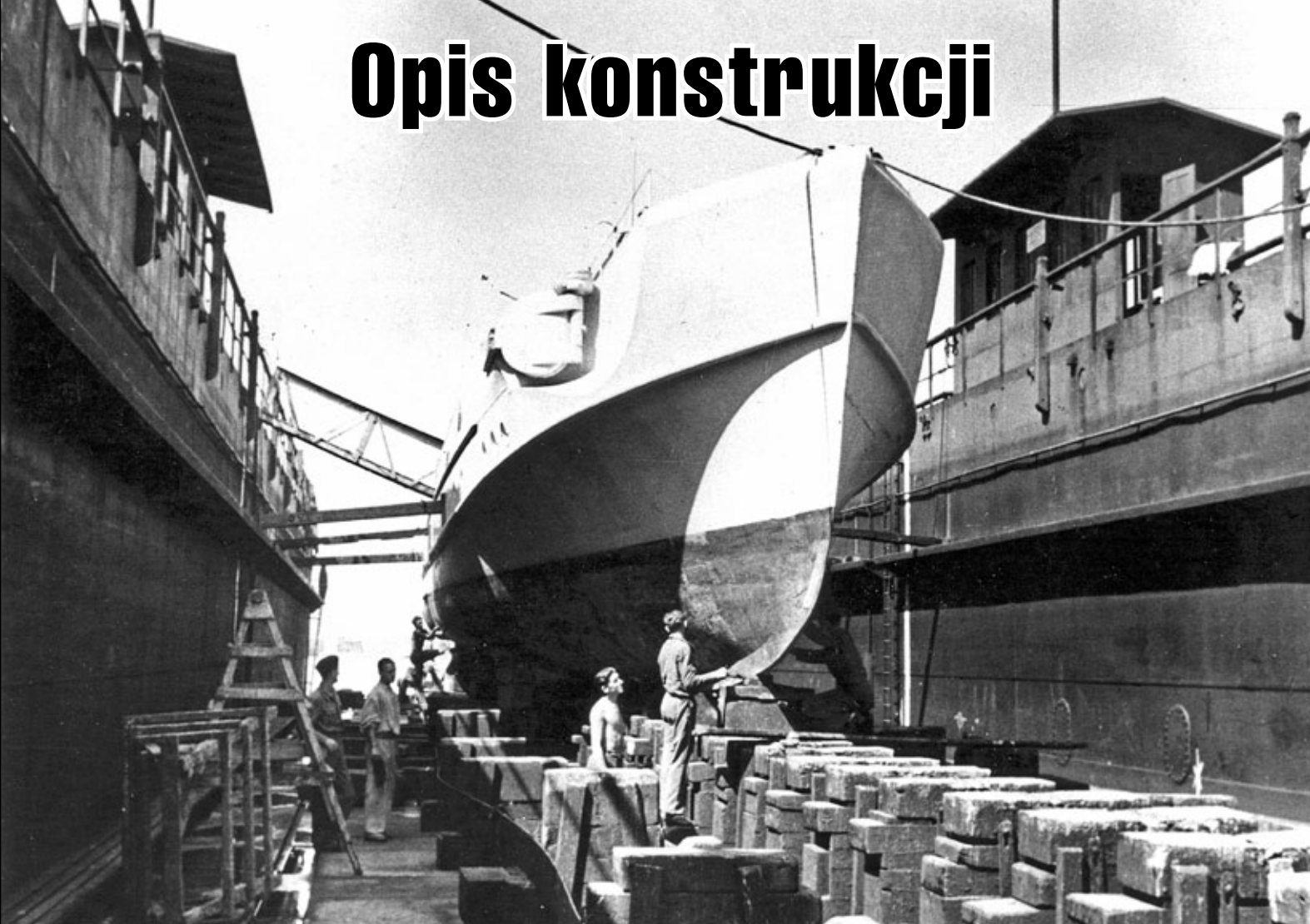
Jeden z okrętów typu S-30 lub S-38 w doku. Widoczny kształt części podwodnej kutra.
