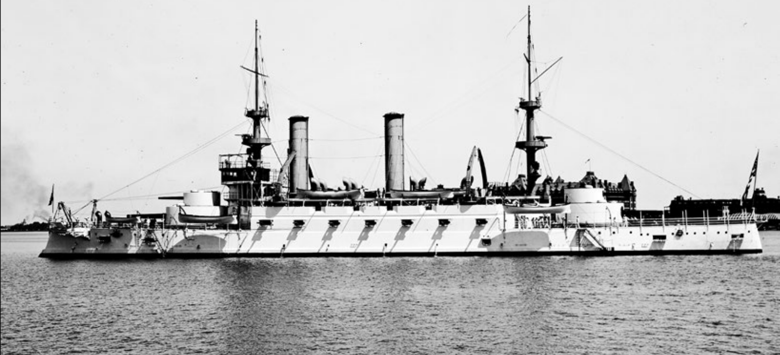
Inaczej niż na poprzednim predrednociu Iowa , pancerniki typu „Kearsarge” otrzymały gładkie pokłady, co wraz z niską wolną burtą spowodowało pogorszenie właściwości morskich w porównaniu z poprzednikiem. Tutaj – Kentucky po wprowadzeniu do służby. Fot. Library of Congress
