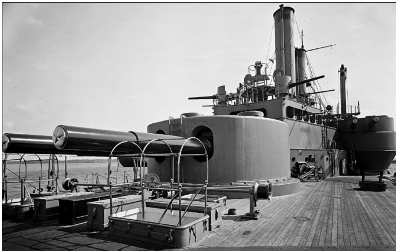
Widok nadbudówki Iowa z pokładu rufowego. Na pierwszym planie wieża artylerii głównej kalibru 305 mm, na prawej burcie tylna wieża artylerii pośredniej kalibru 203 mm. Na pokładzie rezerwowego stanowiska dowodzenia widoczne działa kalibru 102 mm i 6-funtowe. Fot. Library of Congress
