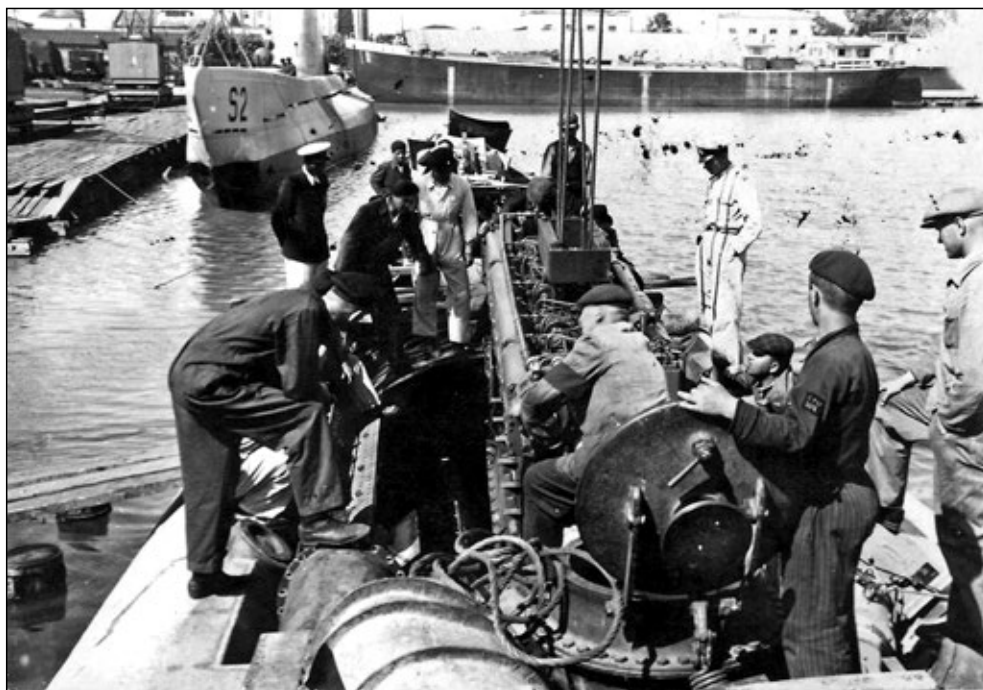
Montaż silnika wysokoprężnego na rumuńskim okręcie podwodnym Rechinul . Fot. zbiory Siergieja Patjanina
