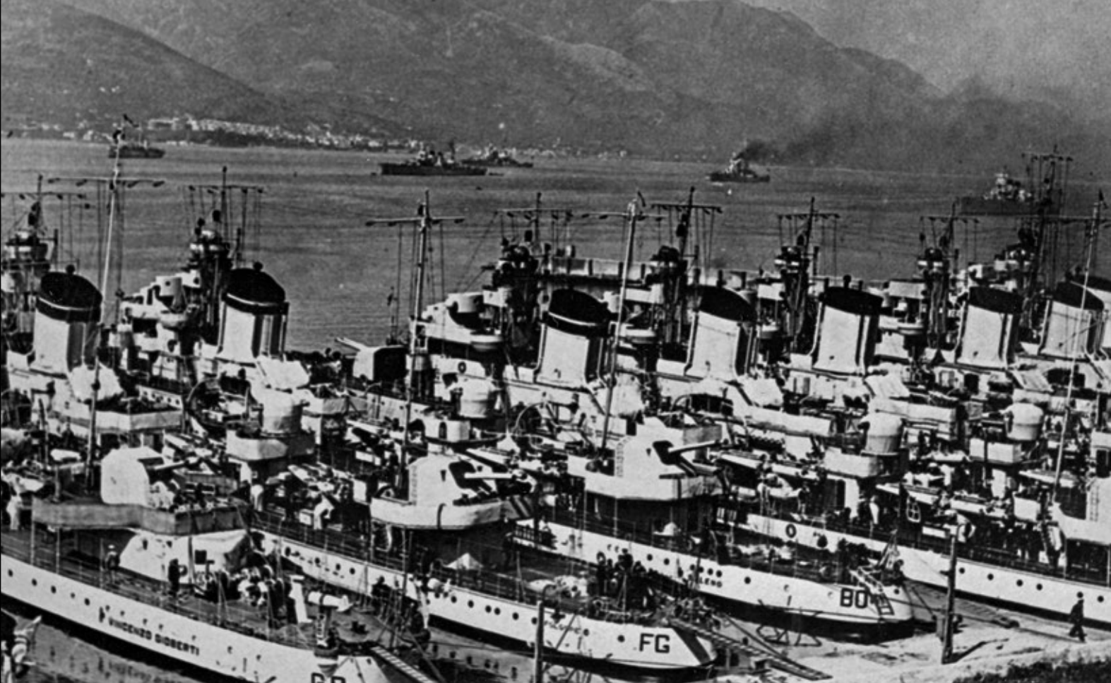
Niszczyciele Folgore i Baleno oraz reszta eskadry w latach 30. Widoczne rozmieszczenie wyrzutni torpedowych oraz zrzutnie bomb głębinowych na poszczególnych okrętach.
