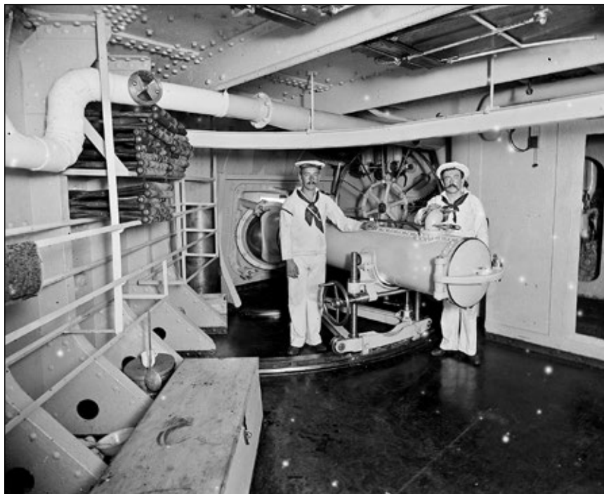
Prawoburtowa, przednia wyrzutnia torpedowa pancernika Massachusetts . Zwraca uwagę mechanizm jej obrotu umożliwiający wyrzucanie torpedy pod kątem, ku śródkręciu jednostki.
