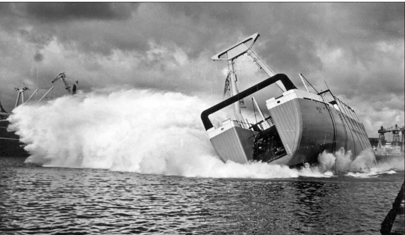
Efektowne wodowanie boczne trawlera Antlia 28 czerwca 1965 r.
