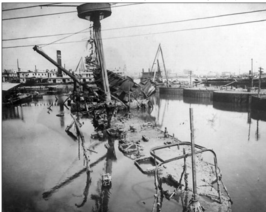
Wrak pancernika Maine otoczony koferdamem. Przed nim widoczna pogłębiarka Barnard . Fot. Library of Congress, Detroit Publishing Company Collection
