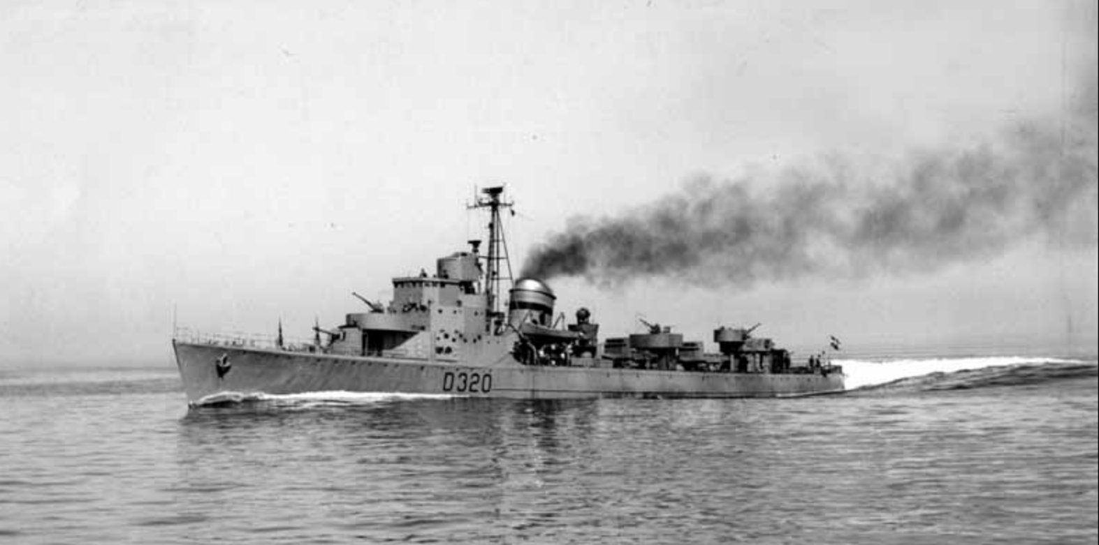
Pełna ekspresji fotografia Huitfeldt wykonana po pierwszej przebudowie w 1951 roku. W jej efekcie dokonano dozbrojenia w trzecie działo 40 mm oraz wymieniono wyrzutnie torped. Jednak na dziobie nadal pozostają dwa działka Madsen kal. 20 mm. W tym okresie Huitfeldt nosił czerwony pas na kominie. Fot. Danish National Museum of Military History
