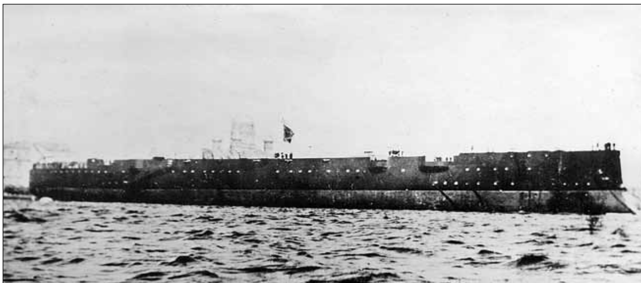
Kadłub Pallady po wodowaniu w oczekiwaniu na przeholowanie do nabrzeża wyposażeniowego.
