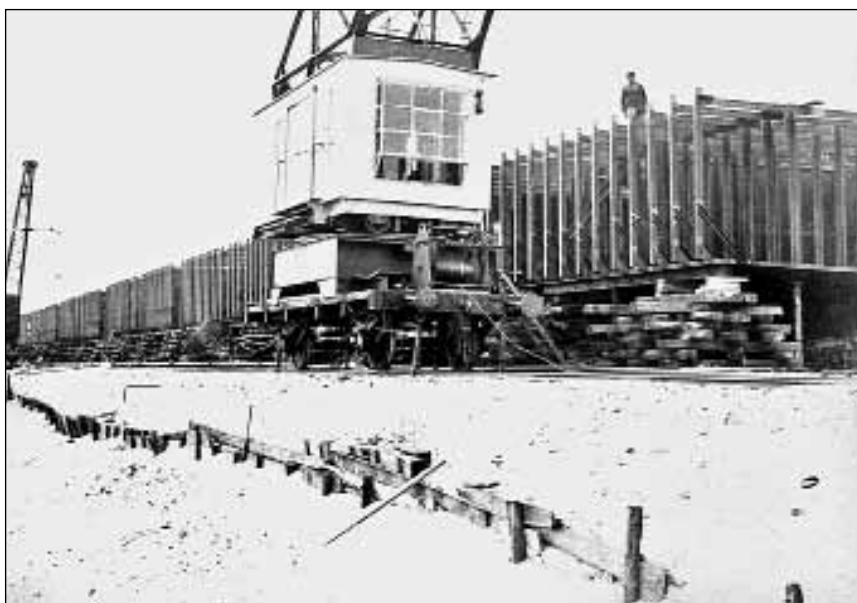
Montaż doku 5000 ton, widok tzw. „Klatek”, po usunięciu których dok się przechylił i zsunął do wody. Fot. Centralne Archiwum Wojskowe
