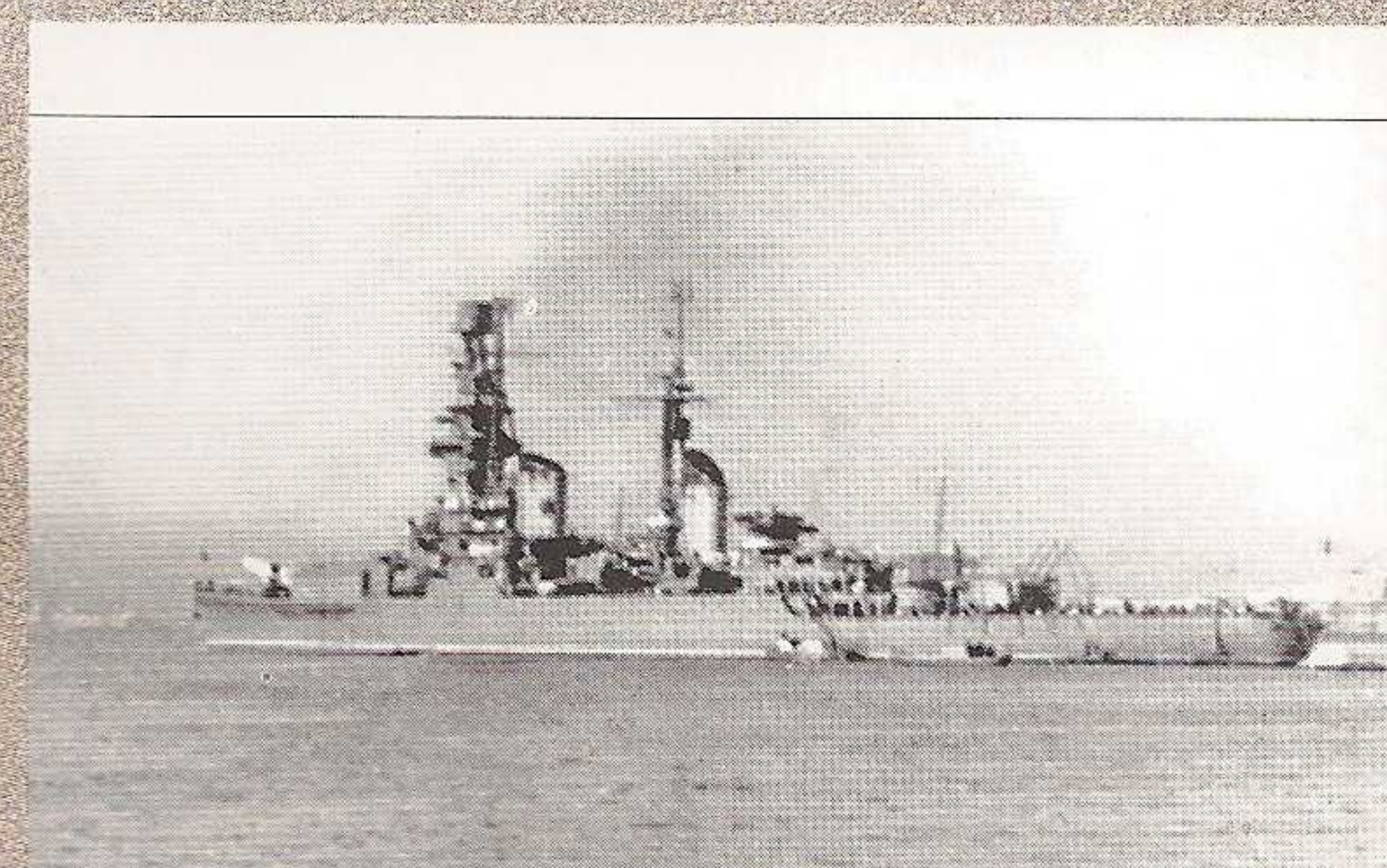
Admirał Nachimow w pierwotnym wariantcie jego modernizacji do standardu proj. 67 – okręt na sewastopolskiej reedzie. Na fotografii widoczne zmiany w konstrukcji jednostki – maszynownia hangaru do przechowywania rakiet w części dziobowej, maszyny z radiem nał staronowiskim. Fot. zbioru Witaij Kostriczko
