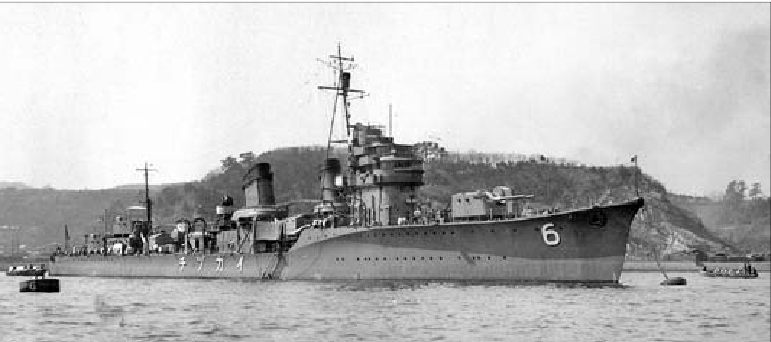
Niszczyciel Ikazuchi typu „Fubuki” w 1933 roku. Jednostki te posiadały bardzo silne uzbrojenie torpedowe złożone z trzech trzylurkowych wyrzutni. Fot. zbiory Shizuo Fukui
