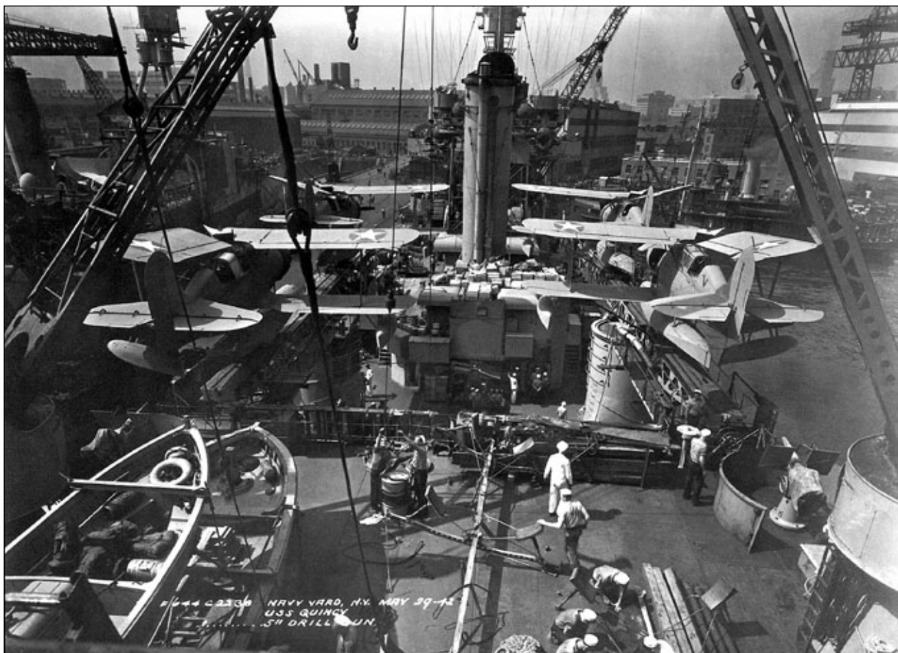
Hangar i kompleks nadbudówki przedniej krążowników typu New Orleans były przedzielone fragmentem pokładu głównego zwanym żargonowo „pokładem studniowym”. Na jego obydwu burtach usytuowano wieżowe podstawy katapult startowych wodnosamolotów. Przed pokładówką kambuza załogowego zamontowano trenera ładowania dział przeciwlotniczych kalibru 127 mm. Tutaj pokład studniowy Quincy .
