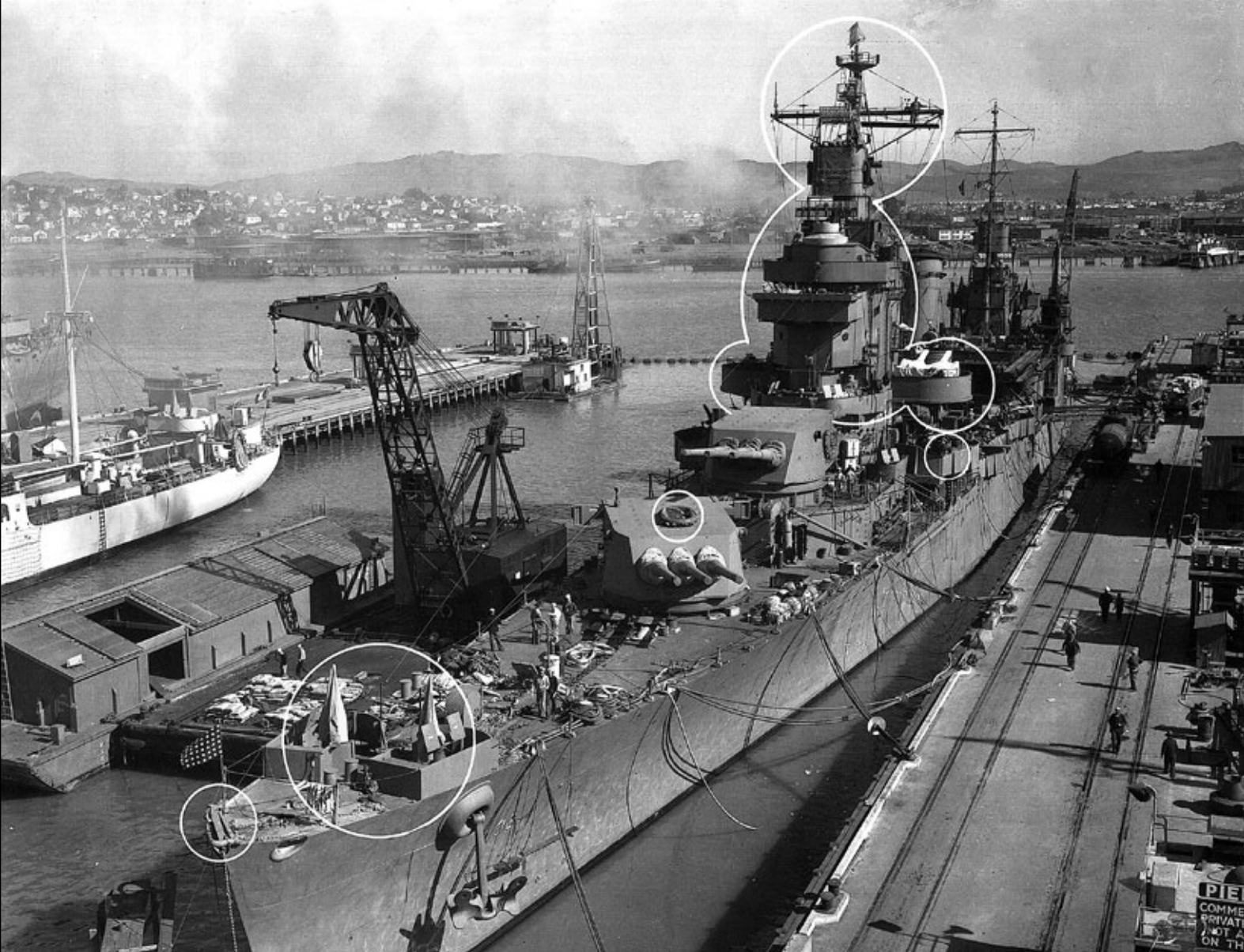
Wykonana w lutym 1943 roku fotografia części dziobowej San Francisco w końcowym okresie modernizacji w stoczni marynarki Mare Island w Vallejo. Okręt otrzymał nowe wyposażenie radiolokacyjne z anteną stacji dozoru powietrznego SC-3 na topie masztu przedniego oraz anteną stacji dozoru nawodnego SG na wsporniku poniżej.
