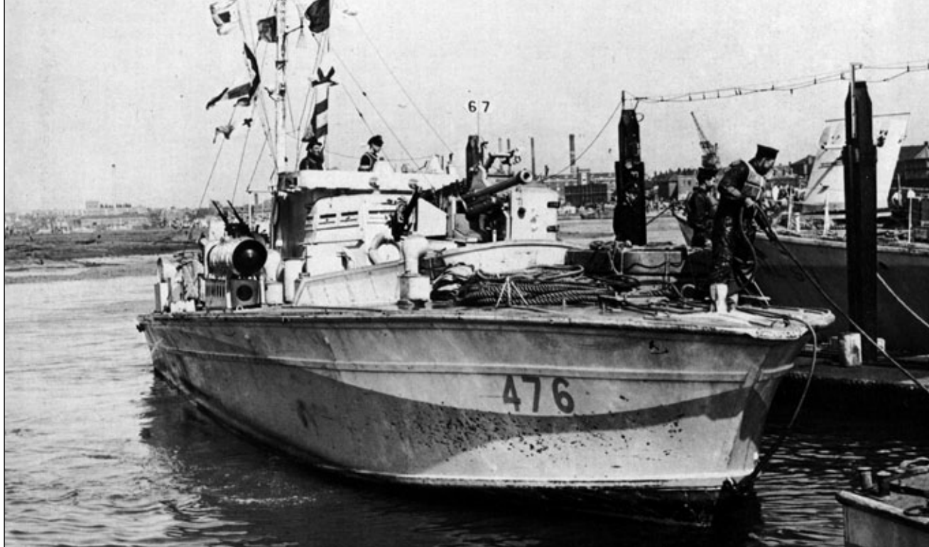
W tym okresie brytyjskie kutry stały się coraz groźniejszym przeciwnikiem. Na fotografii kuter torpedowy MTB 476, uwagę zwraca działo kal. 57 mm na dziobie. Fot. zbiory Mike Russell
