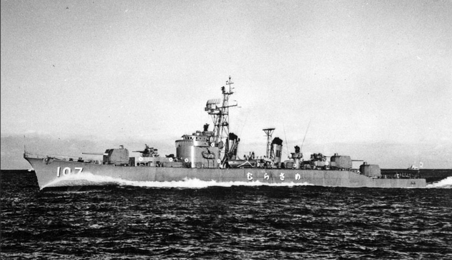
Murasame był prototypem 3 okrętowej serii, będącej dobrojoną wersją typu „Ayanami”. Fotografia z początkowego okresu służby dobrze ukazuje rozmieszczenie uzbrojenia. Fot. „Ships of the World”
