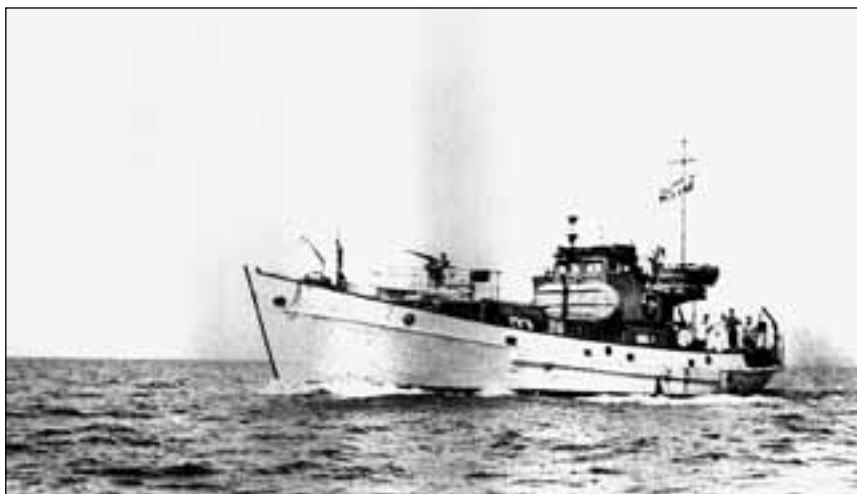
Jeden z KFK (Kriegsfischkutter); na potrzeby Kriegsmarine zbudowano setki tych bardzo uniwersalnych jednostek, kilka w Bułgarii i w neutralnej Szwecji. Na Morzu Egejskim służyły jako eskortowce i ścigacze okrętów podwodnych.
