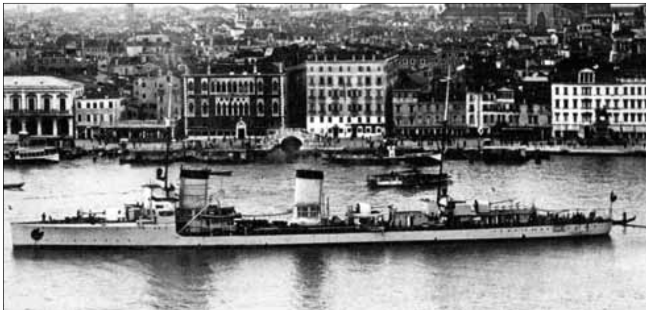
Wielki niszczyciel Premuda w roku 1936 w Wenecji. Dotychczasowy aparat torpedowy między drugą armatą kal. 150 mm a masztem głównym został zastąpiony nadbudową. Fot. „Esploratori...”
