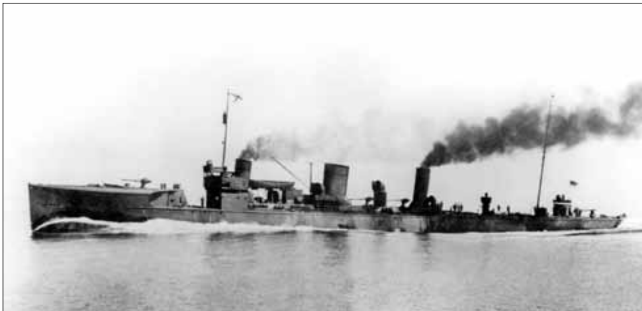
V 99 należał do tego samego typu, co B 97, ale zbudował go szczeciński Vulcan A.G.; maksymalna wyporność: 1874 t, a prędkość 37,2 w.
