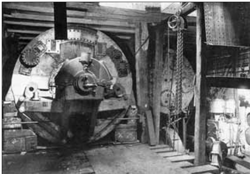
Montaż lewoburtowej turbiny na Bremse , 10 lutego 1916 r.
