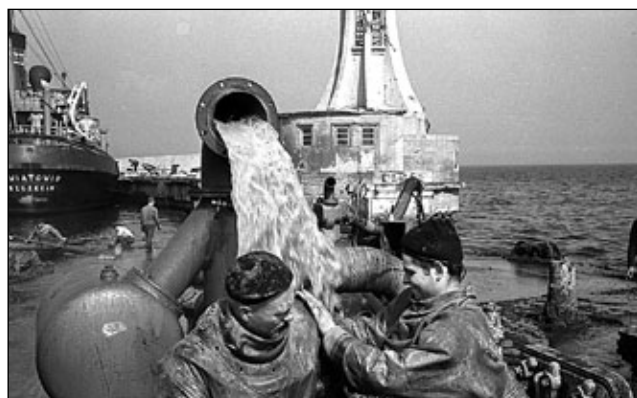
Pancernik już po demontażu wszystkich nadbudówek. W części dziobowej trwa budowa kesonu.
