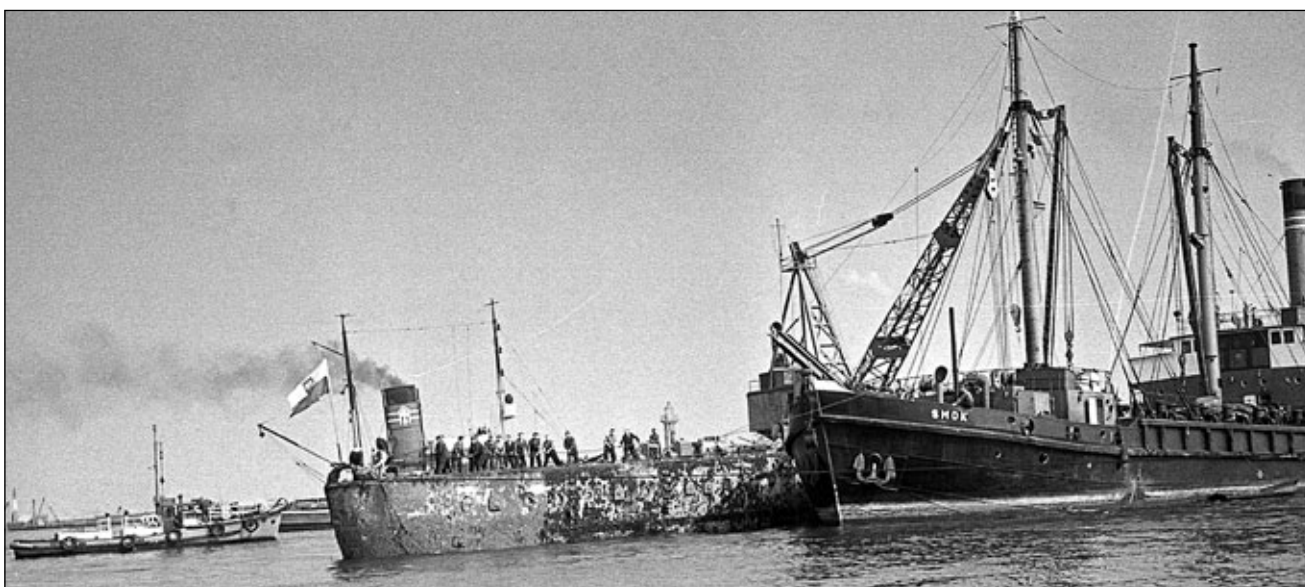
Demontaż nadbudówek. W operacji uczestniczył statek baza Smok wraz z dźwigiem pływającym. Dobrze widoczna boczna płyta pancerna pancerza burtowego demontowana z wraku (fot. dolna). Lata 40-te. Fot. Janusz Uklejewski
