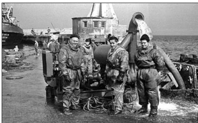
Montaż pomp na wraku i wypompowywanie wody, rok 1950.
