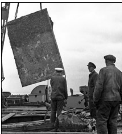
Demontaż nadbudówek. W operacji uczestniczył statek baza Smok wraz z dźwigiem pływającym. Dobrze widoczna boczna płyta pancerna pancerza burtowego demontowana z wraku (fot. dolna). Lata 40-te. Fot. Janusz Uklejewski
