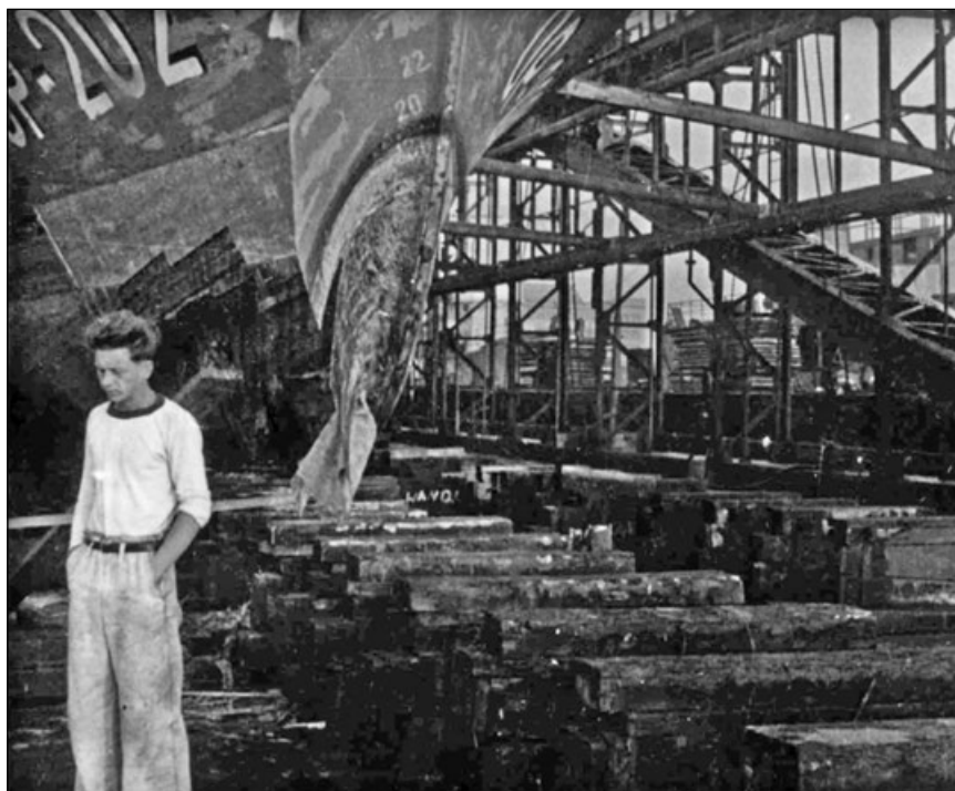
Patrolowiec OP-202 na slapie stoczni PPUR „Barka” w Kołobrzegu z uszkodzonym dziobem, podczas wejścia w sztormie w kanale wejściowym portu kołobrzieskiego po zakończeniu akcji pościgowo ratowniczej w dniu 21 sierpnia 1958 roku.
