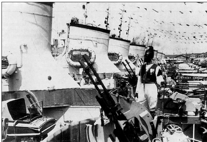
Niszczyciele typu „Soldati” pierwszej serii, Ascari , Alpino oraz inne. Widoczne podwójne działka przeciwlotnicze kal. 20 mm L/65 wz. 1935. Fot. zbiory Erminio Bagnasco
