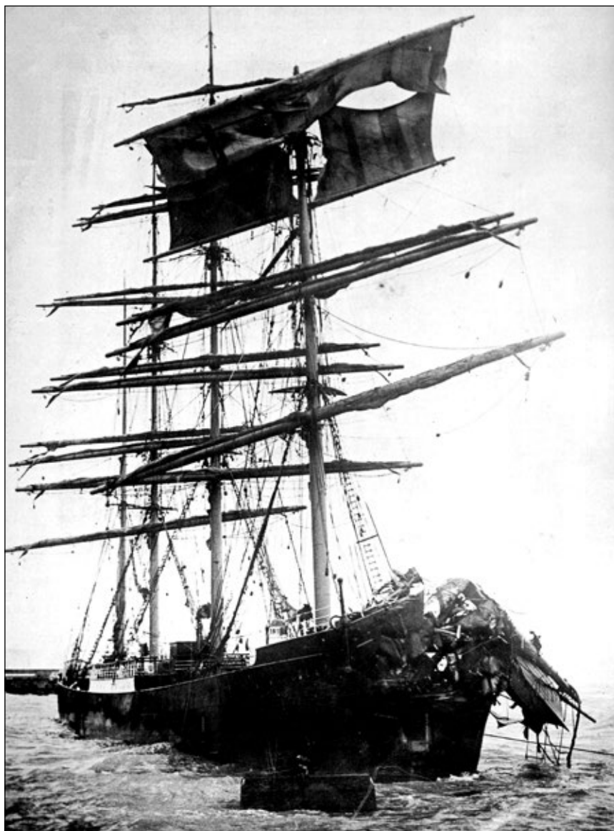
Pisagua po zderzeniu z pasażerskim liniowcem Oceana 16 marca 1912 roku. Widoczny zniszczony bukszpryt i dziób. Fot. Archives de la Voile
