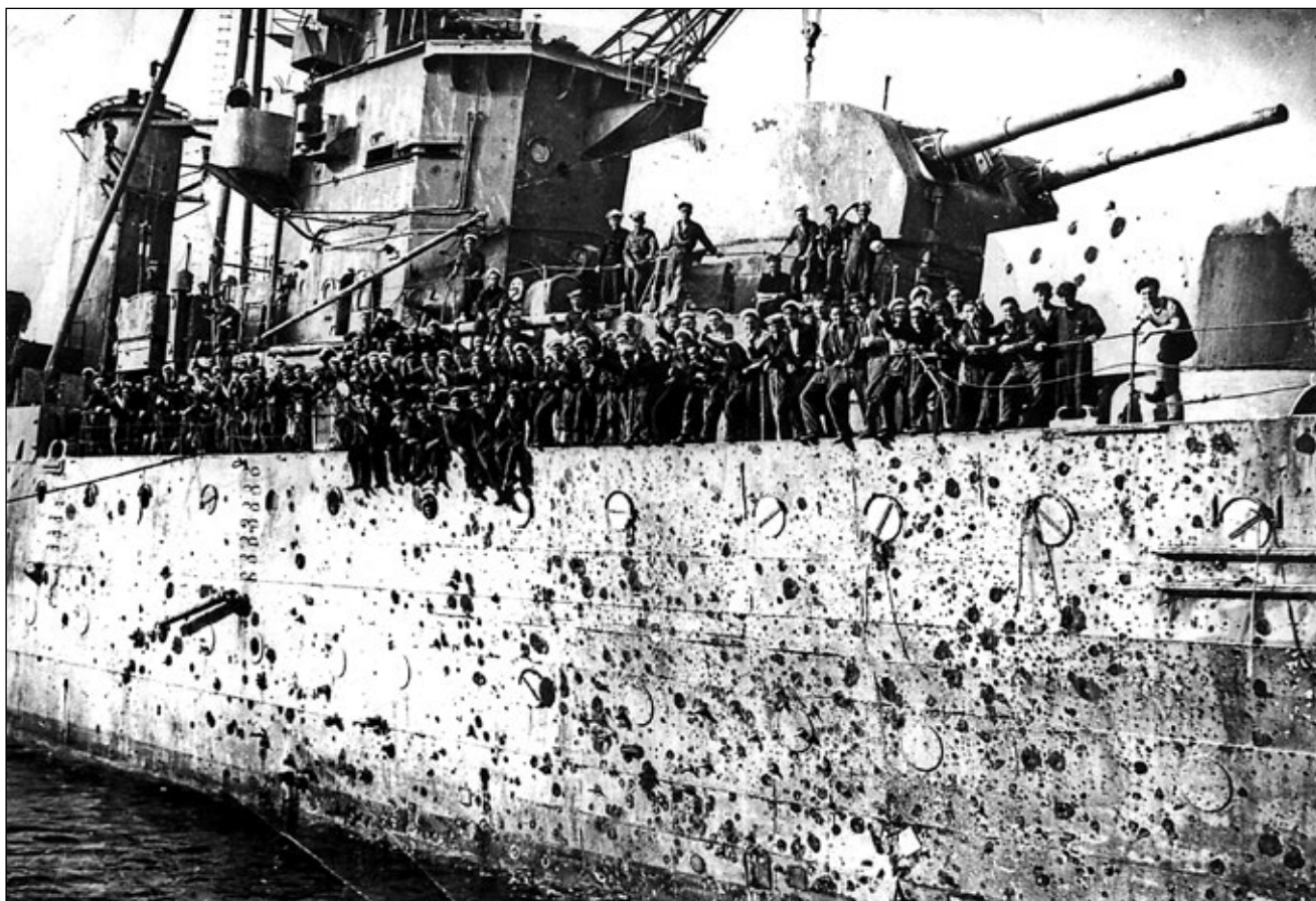
Dwie ciekawe fotografie krążownika lekkiego Penelope wykonane w Gibraltarze 10 kwietnia 1942 roku. Widoczny ogrom otworów w kadłubie powstałych od odłamków pocisków. Fot. National War Museum Association
