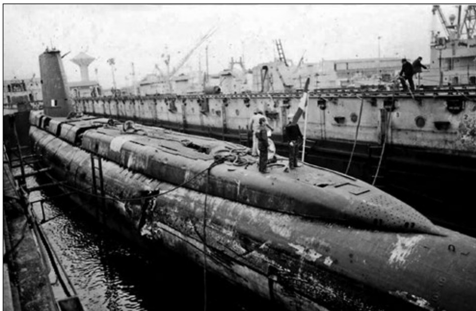
Pacocha w doku, widoczne uszkodzenie w lewej burcie.
