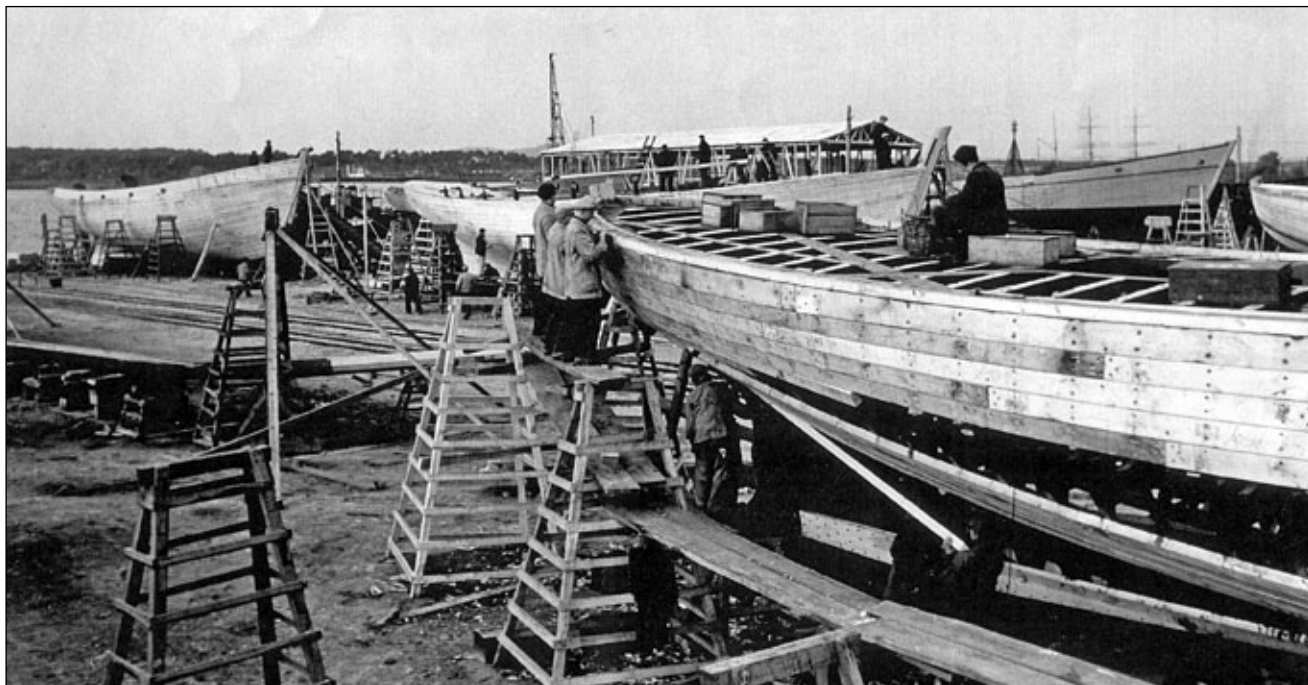
Kutry typu KFK w początkowym stadium budowy w świnoujskiej stoczni Ernst Burmester Schiffwerft KG.
