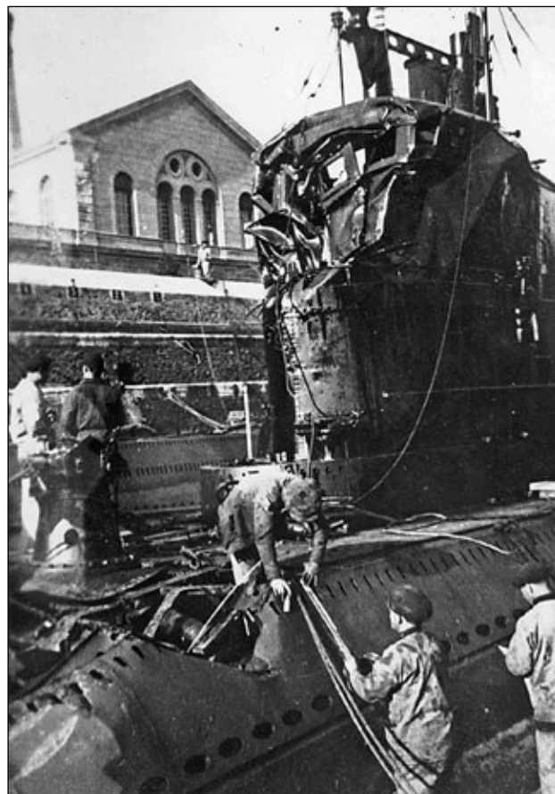
Dagabur z uszkodzeniami odniesionymi od bomb głębinowych w trakcie naprawy.
