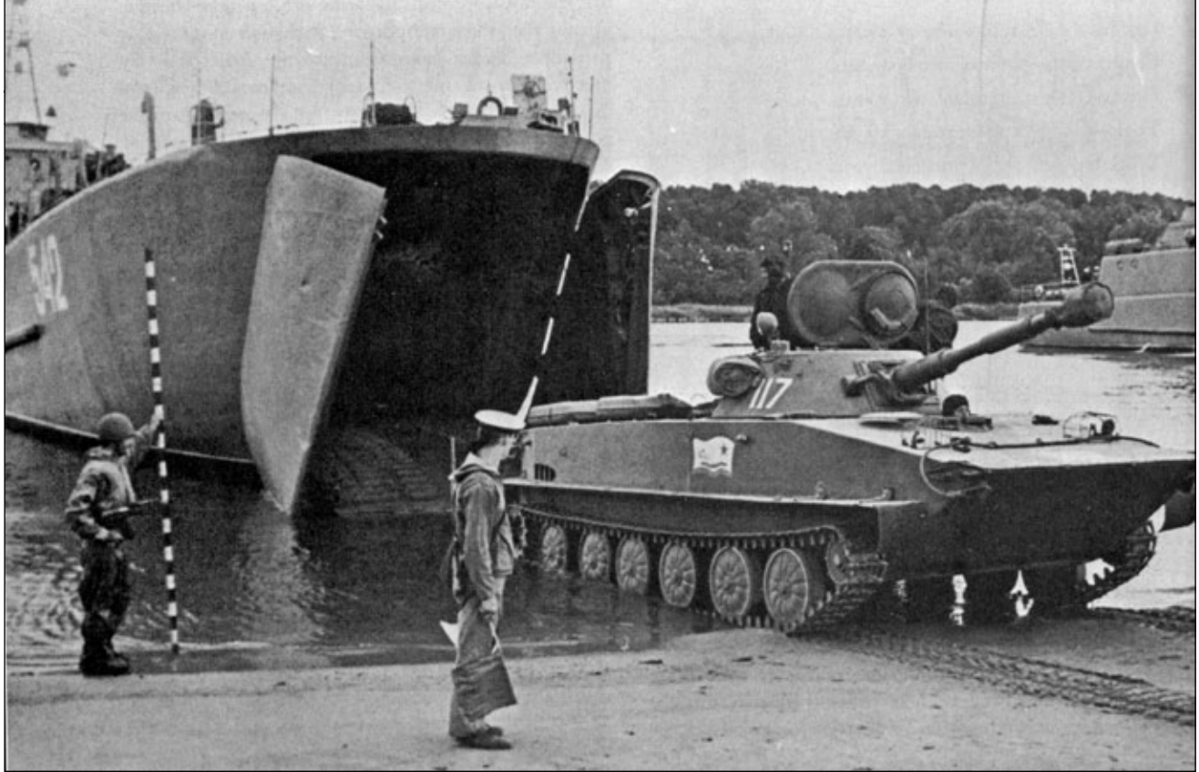
Łaładunek czołgu pływającego PT-76 na pokład okrętu polskiej produkcji proj. 770. Na fotografii prawdopodobnie przydzielony 71. BOD Floty Bałtyckiej SDK-36 (472) ze zmienionym na czas ćwiczeń numerem burtowym. W trakcie służby okręt przeszedł w podporządkowanie 242. dywizjonu okrętów Desantowych Flotylli Kaspijskiej. Fot. zbiory Jarosław Malinowski
