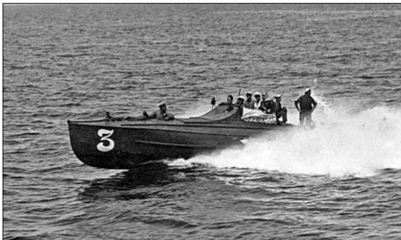
Brytyjskie kutry torpedowe typu „CMB” były punktem wyjścia przy opracowywaniu pierwszych radzieckich konstrukcji tej klasy. Na fotografii jedna ze zdobycznych jednostek w składzie Floty Czarnomorskiej, lata 20-te. Fot. zbiory Siergiej Bałakin
