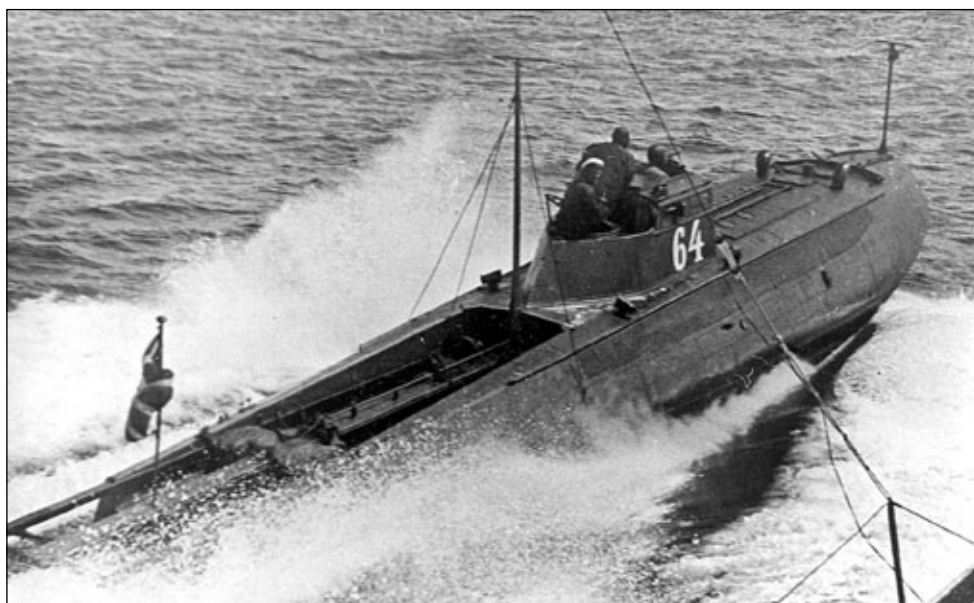
Kuter typu Sz-4 wychodzący na morze. Uwagę zwracają szczegóły konstrukcji urządzenia rozruchowego silników torped i widoczne tłoki mechanizmu wypychającego na wyrzutni. Fot. zbiory Ota Janeček
