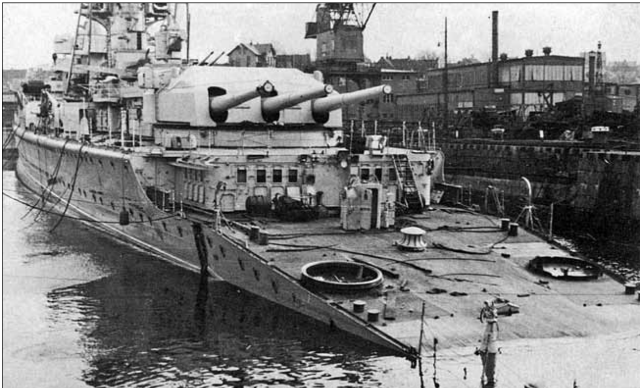
Widok na nadłamaną rufę ciężko uszkodzonego Lützowa po przybyciu do stoczni Deutsche Werke w Kilonii.
