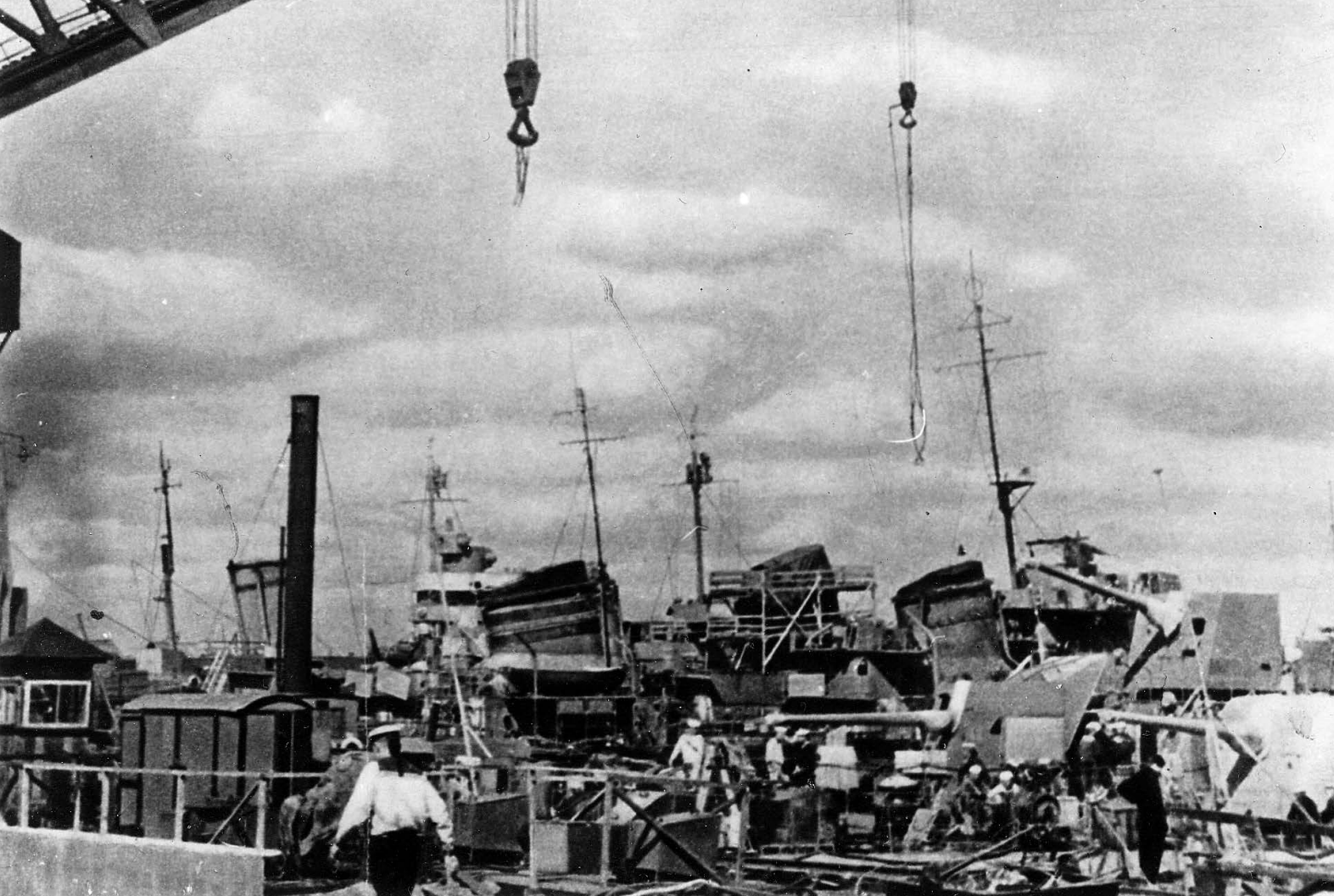
Niszczyciele projektu 7 w trakcie budowy w stoczni Nr 199 w Komsomolsku nad Amurem. Na drugim planie (po lewej) widoczny lider projektu 38. Fot. zbiory Siergieja Bałakina
