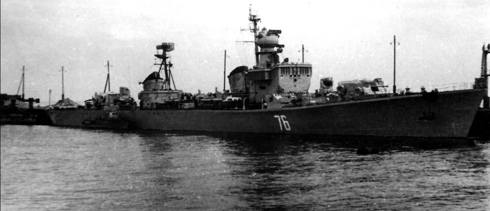
Nieustraszimyj w pierwotnej konfiguracji w 1954 roku. Przed pomostem widoczne dwulufowe działo SM-16 kal. 45 mm, a pomiędzy wyrzutniami torped czterolufowe 4M-120 kal. 25 mm. Fot. zbiory Witalija Kostriczenki
